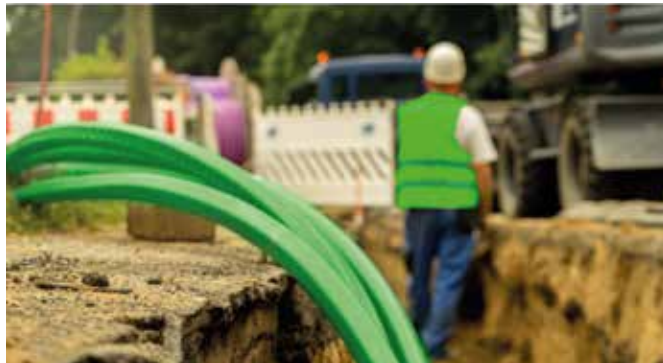
Foto: Glasfaser Ruhr
