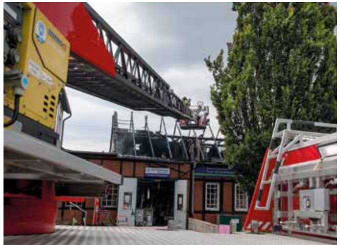
Am 7. Mai 2020 verursachte der Brand in Stiepel einen immensen Sachschaden. Personen wurden nicht verletzt. Foto: Feuerwehr
