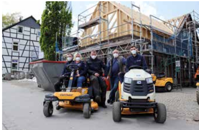
Die Gathmann-Mitarbeiter freuen sich darauf, dass das Werkstattgebäude in Kürze fertiggestellt ist. Foto: 3satz
