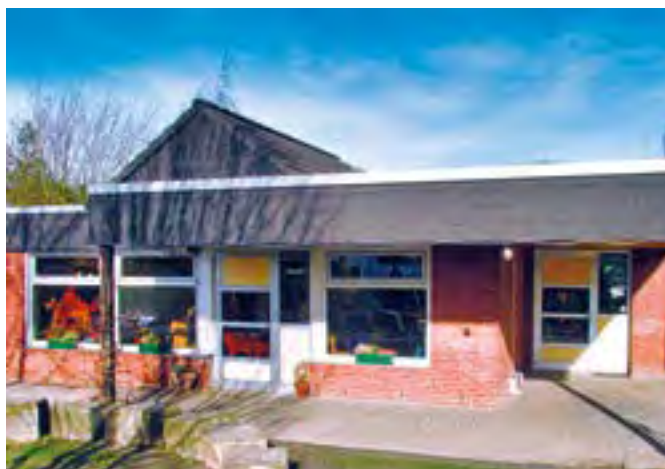
Noch bis März 2025 gehen die Arbeiten in der KiTa Gräfin Imma in Stiepel.
