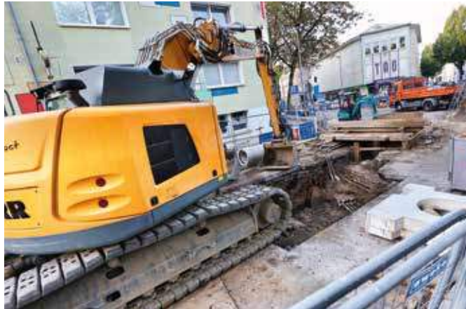
Seit Mitte Mai ist die Alte Hattinger Straße auf 70 Metern eine Baustelle und verkürzt auch die Clemensstraße. Foto: 3satz/Lukas
