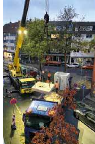
Im Oktober wurden zwei Kanalschächte mit einem Kran auf der Kreuzung an der Clemensstraße verbaut. Fotos (2): Jutta Wegener
