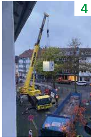
Schwerer Autokran kommt im Kanalbau zum Einsatz
