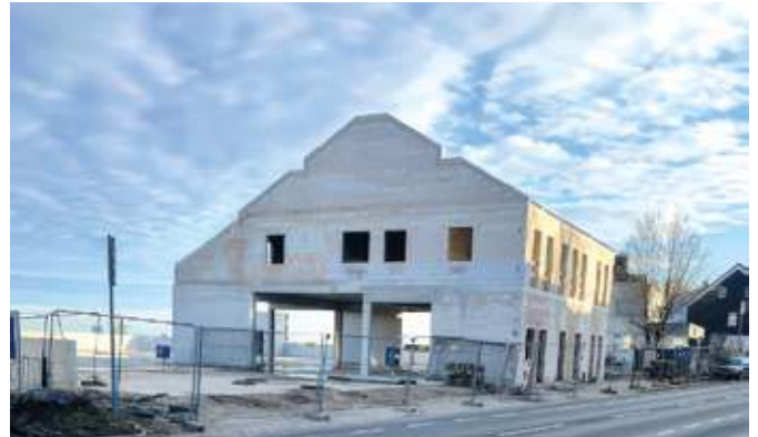
Der Rohbau steht, auf die Eröffnung des Aldi-Marktes müssen die Stiepelers noch bis zum Sommer warten. Foto: privat
