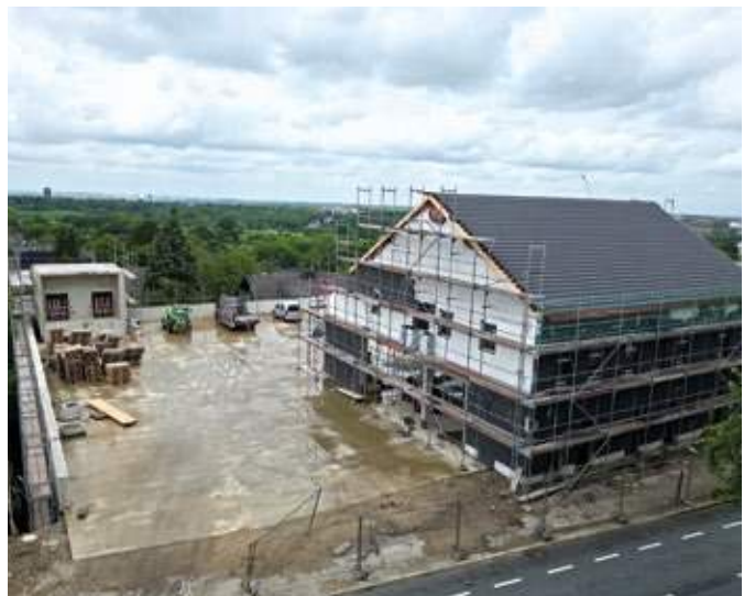
Aus der Vogelperspektive lassen sich die Baufortschritte gut erkennen. Foto: privat
