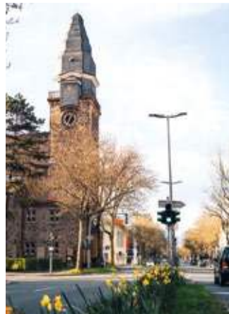
Dieser Blick auf den Turm läutete die Reparaturarbeiten ein.
