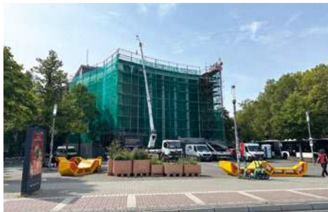
Eingerüstet ist das Schauspielhaus während der Sommerpause, weil an der Dämmung des Daches gearbeitet wird. Foto: 3satz
