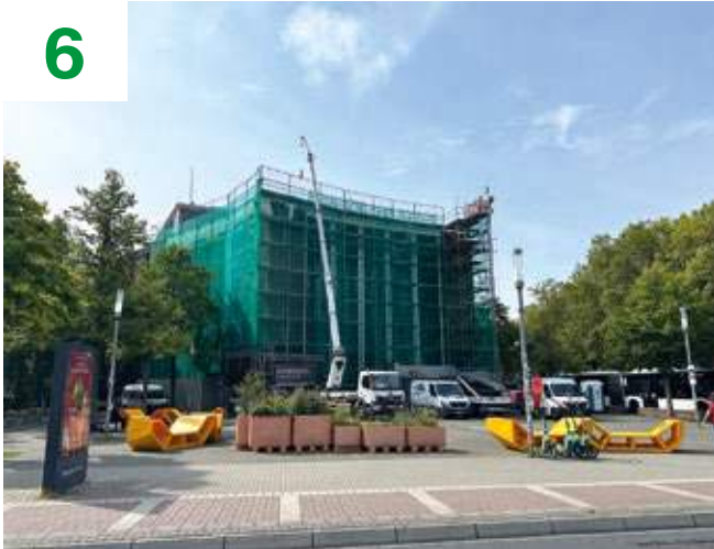
Dichtes Dach und neue Toiletten
