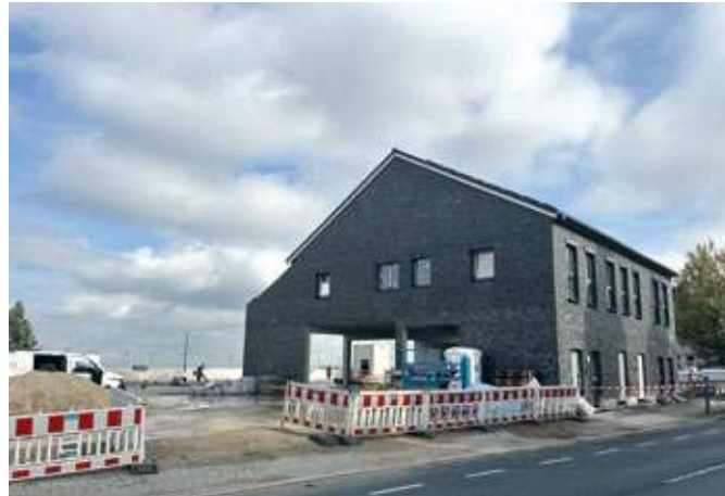
Die Arbeiten auf dem Parkdeck an der Kemnader Straße schreiten nur sehr langsam voran. Foto: 3satz
